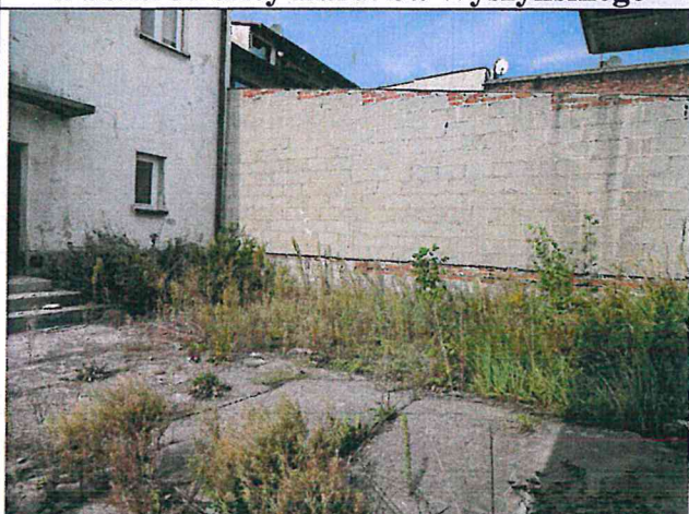
Widok utwardzenia terenu
