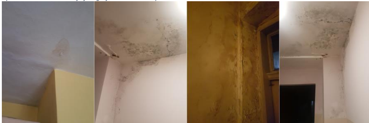
Rysunek 11. Dokumentacja fotograficzna - stan budynku
