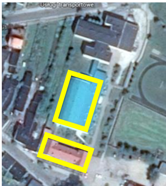
Rysunek 25. Możliwe miejsce montażu instalacji fotowoltaicznej; Gimnazjum nr 1 w Kłodawie, ul. Kościelna 15
