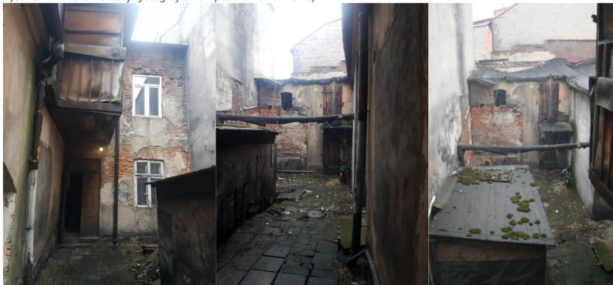
Rysunek 12. Dokumentacja fotograficzna - podwórko kamienicy
