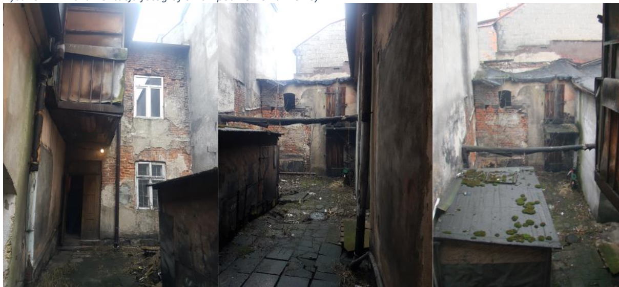
Rysunek 12. Dokumentacja fotograficzna - podwórko kamienicy
